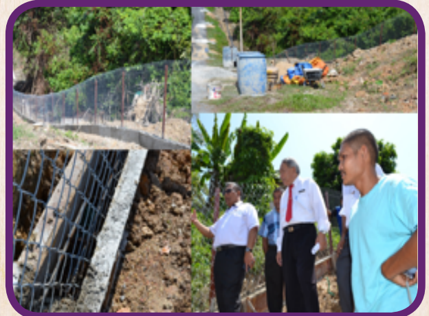
Kerja Pembaikan Pagar di SMK Taman Bunga Raya, Rawang
