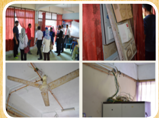
Kerja Penyelenggaraan Elektrik di SK Kompleks Mengabang Telipot, Terengganu
