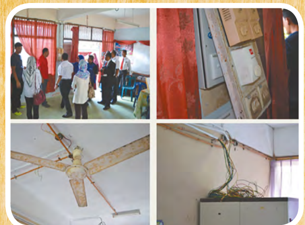
Electrical wiring maintenance at SK Kompleks Mengabang Telipot, Terengganu
